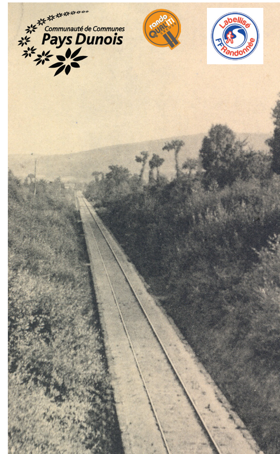
Photo prise depuis le pont sur la RD951 (actuel parking du collège)
